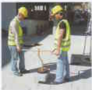
Probst Greiftechnik Verlegesysteme GmbH stellte das neue Vakuum-Handy VH vor. Es ist sehr hilfreich beim Verlegen von saugdichten Steinplatten
