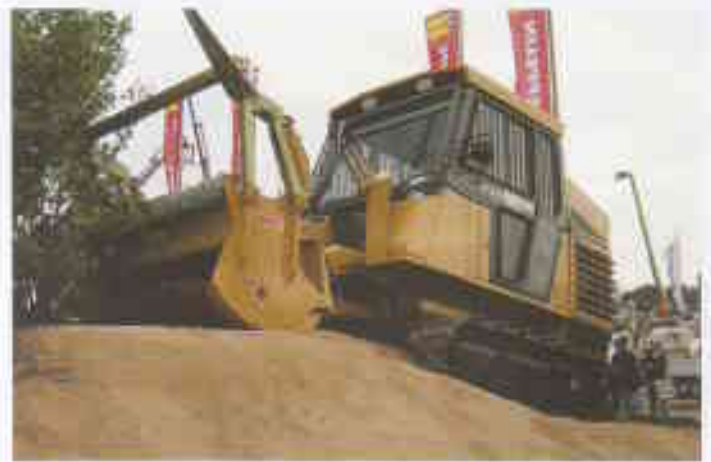
Der Geräteträger bei MVS Zeppelin stammt von der Firma Green Mech, der speziell für den Bahndammbau entwickelt wurde. (Fotos: Mark Schmiechen)
